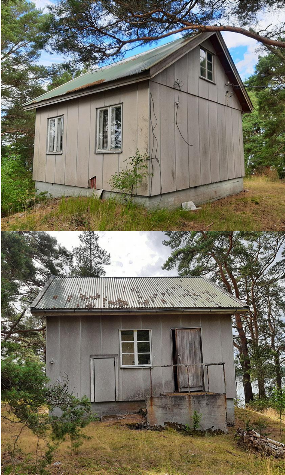
Bilder 4-5. Stationsbyggnaden (vaktstuga) vid vinterfarledens färjplats anvisas i planen som ekonomibyggnad. Fasadmaterialet är en favoritprodukt som framställdes på 1950-60-talet av en Pargasbördig industrianläggning. Efter krigen producerades små mineritskivor som fasadmateriäl, se bilderna 2-3, även dessa en framgångsprodukt av sin tid. På holmen finns flera lämningar av ekonomibyggnader som under tidens gång rivits samt gamla kablar och ledningar. Byggnadens storlek är 32 m 2 .
