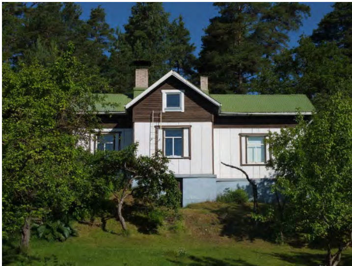
Kuva: Huvilakadun varrella 1923 rakennettu huvila, joka on saanut myöhemmin vuosikymmeninä muodistettut julkisivut. 60-luvun tasakattomuodin vaikutuksesta vanhoja, korkeita rakennuksia uudistettiin verhoilemalla vaalealla levyllä siten, että päätökolmio verhoiltiin tummalla laudalla. Tässä ikkunoitten vanhanaikaista, pystyä vaikutelmaa on vielä haluttu muuttaa listoituksin.
