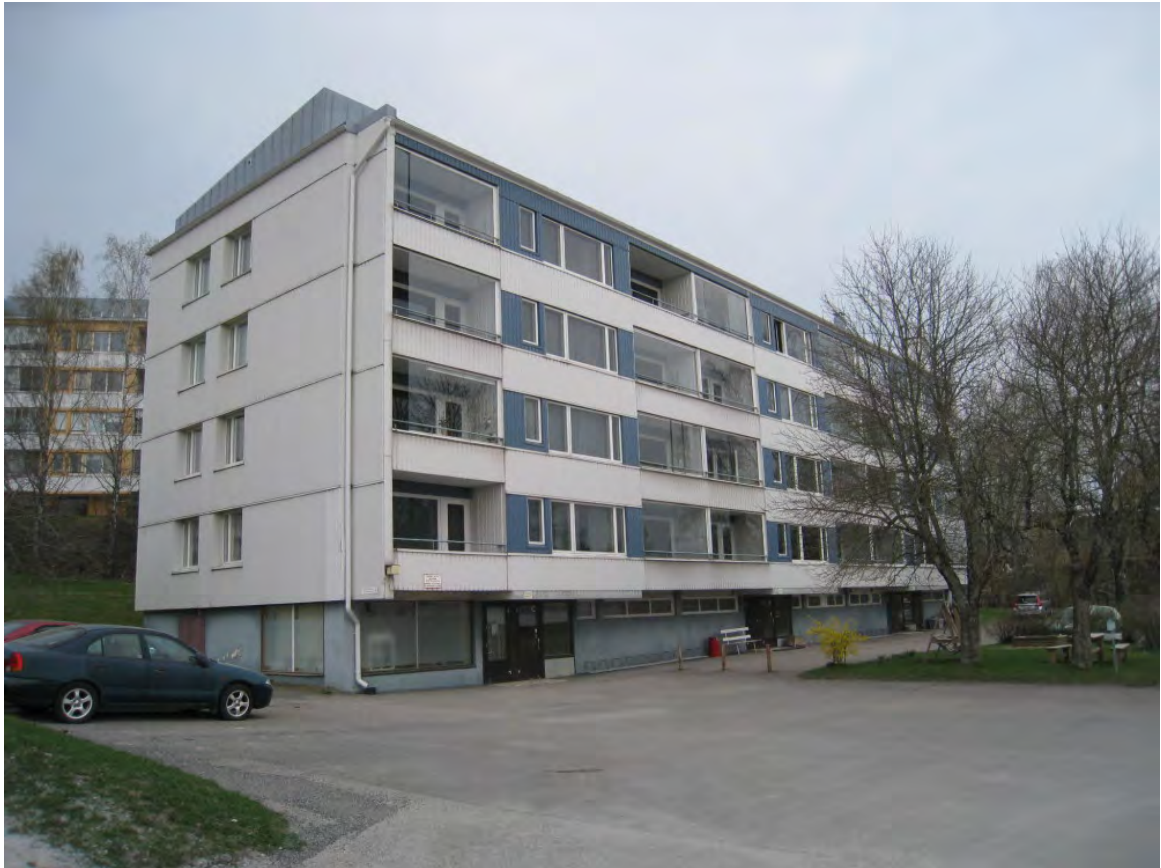
Kuva: Alueen vanhin ja näkyvin rakennus vuodelta 1961 Österbyntien varrella. Rakennus paljastaa, vaikka uudelleen verhoiltuna, 60-luvun alun tyylliset piirteet: nauhaikkunajulkisivu, sisäänvedetyt parvekkeet, horisontaalinen hahmo sokkelikerroksen ja kattorakenteen erilaisella käsittelyllä. Sokkelikerroksessa on alkuperäinen liiketilan näyteikkuna. Valokuva: Laura Ruohonen TMK/MIP
