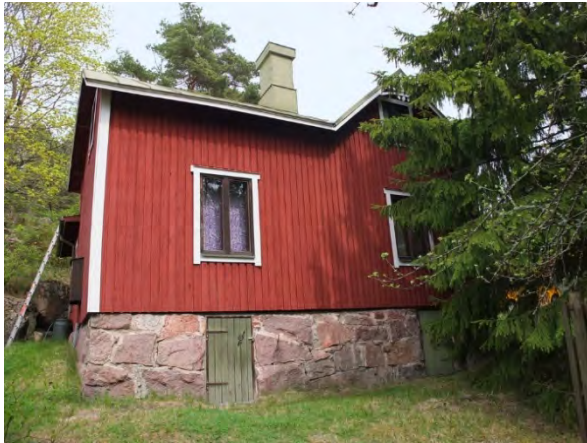
Kuva: Vanha torppa on saanut ajan oloon uuden ulkovuorauksen, katteen ja ikkunat. Rakennusinventoinnissa todetaan, että rakennukseen on tehty muutoksia. Luonnokivistä ladottu kivijalka paljastaa, että kyseessä on vanha rakennus ajalta ennen betonin käyttöönottoa. Valokuva: Teija Mustonen, TMK/MIP
