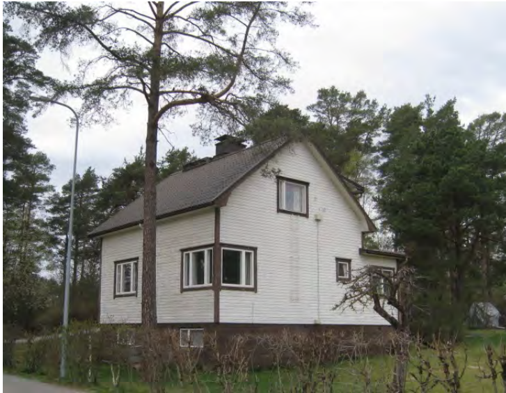
Kuva: Omakotitalo vuodelta 1951. Tässä rakennuksessa näkyy kaksi paraislaista yksityiskohtaa: katon päädyn räystäsverhouksen kaareva peitelauta ja kulmaikkuna. Molemmat erityiset piirteen ilmenevät 30-luvulta aina 60-luvun alkuun eri puolella Paraista. Valokuva: Laura Ruohonen TMK/MIP
