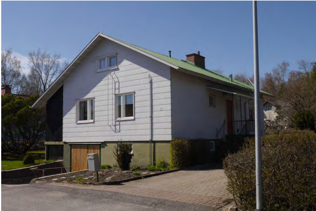
Kuva: Kauniisti alkuperäistä arkkitehtuuria kuvaava rakennus. Tässä vuonna 1963 valmistuneessa talossa näkyy vielä ajankohdan tärkeät yksityiskohdat: kellariautotalli ja massasta sisään vedetty avoin terassi, joka tässä on saanut tumman ritilän katesuojaksi. Valokuva: Janika Brüggmann TMK/MIP
