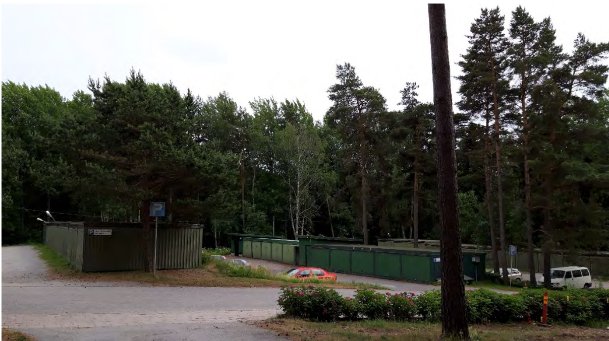
Kuva: Erillisille autopaikatonteille on rakennettu talleja.
