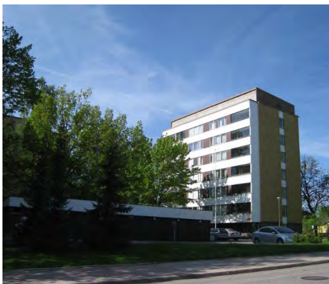
Kuva: Sibeliuksenkadun kerrostalo on vuodelta 1971. Se on ajalta ennen ruutuelementtikautta. Julkisivujen nauhaikkunat, tiilipäädyt ikkunakenttineen ja muotoiltu, selkeä ullakkokerros. Nämä piirteet näkyvät Paraisilla vain Österbyntien parissa kerrostalossa. Kuvassa Paraisien ensimmäisiä kerrostaloja. Valokuva: Teija Mustonen TMK/MIP
