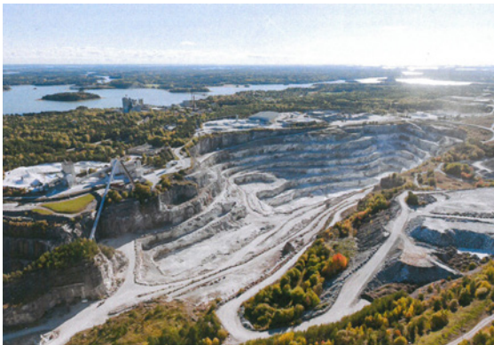
Kalkkivilouhos (kuva: Nordkalk)
