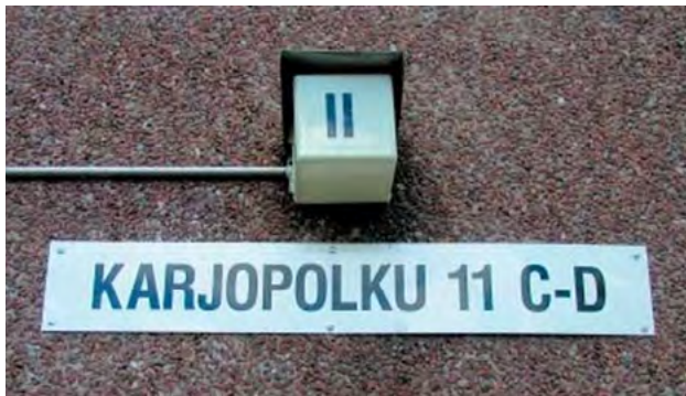
Kuva 4. Rakennuksen osoitemerkintä kadun nimi ja -numero -mallin mukaisesti (nimenumerokilpi).
