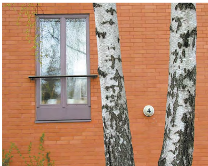
Figur 3. Byggnadens ägare ska placera adressnumret så att det syns.
