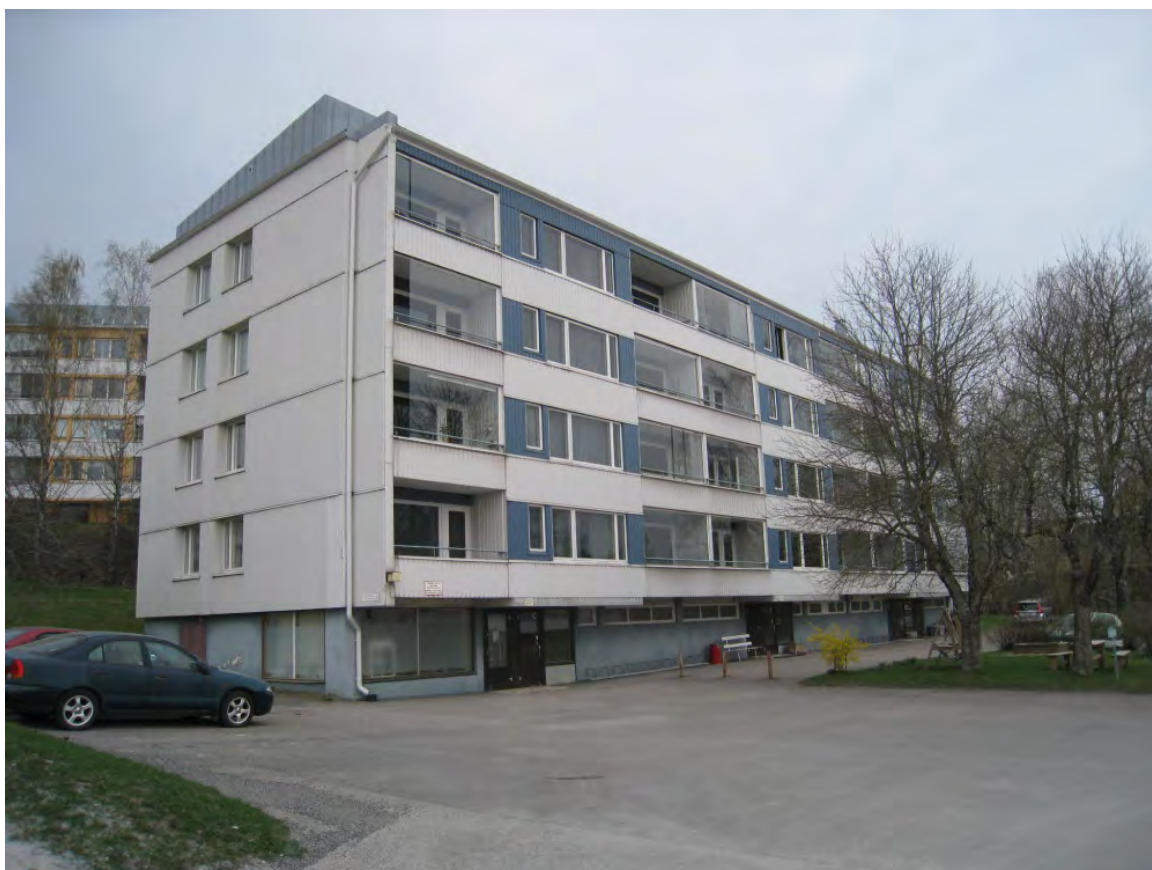
Bild: Det äldsta och synligaste huset vid Österbyvägen, från 1961. Även om huset har fått en ny beklädnad kan man se 1960-talets stildrag: fasad med bandfönster, indragna balkonger, horisontell gestaltning genom att sockeln och taket har fått en annorlunda beklädnad i förhållande till resten av fasaden. I sockeln finns ett skyltfönster till den affärslokal som tidigare funnits i huset. Foto: Laura Ruohonen, Åbo museicentral/MIP
