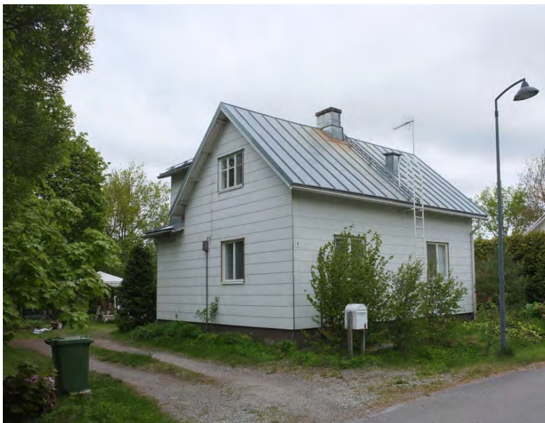
Bild: Ett hus från 1948. Mineritskivan blev vanlig i Pargas och den användes senare som ersättande material i fasadändringar. Minerit kan också vara det ursprungliga fasadmaterialet. Foto: Teija Mustonen, Åbo museicentral/MIP
