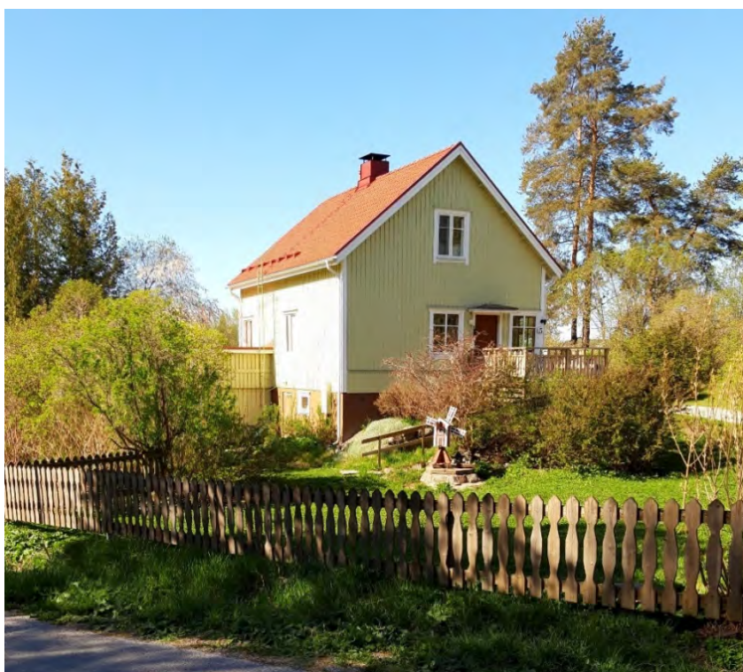
Bild: Även detta egnahemshus är från 1947, huset har klassificerats som byggnads-historiskt värdefullt. De ursprungliga särdragen har bevarats väl. Foto: lina Paasikivi
