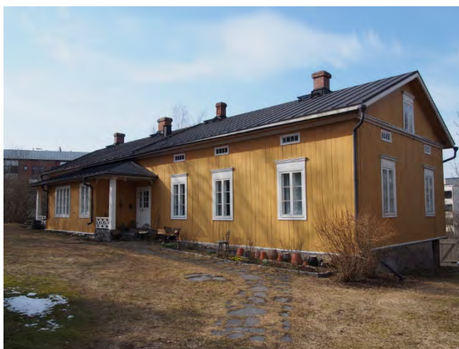
Bild: Tennby gårds huvudbyggnad från 1814. Gabriel Bonsdorff, professor vid Akademien i Åbo, planerade och lät bygga huset. Tack vare Pargasbornas motsättning undgick huset en rivning, staden köpte huset av byggnadsfirman och sålde det för bostadsändamål. Det ursprungliga utseendet har återställts i reparationer. Foto: Teija Mustonen, Åbo museicentral/MIP
