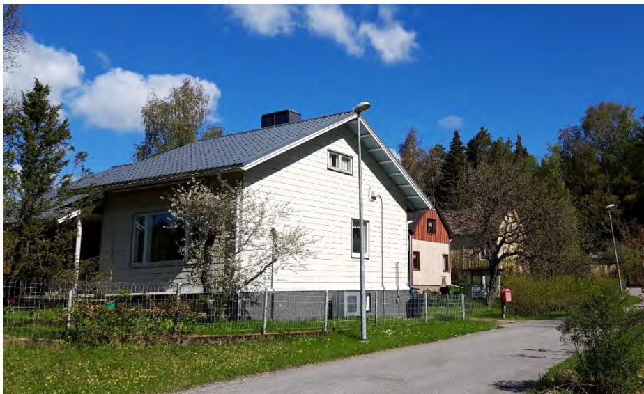
Bild: Ett egnahemshus från 1964, byggt i ett plan, taklutningen har blivit lägre. Asbestcementskiva som fasadbeklädnad. I bakgrunden syns ett hus från 1940-talet, vars fasad har moderniserats på 1970-talet med s.k. karatskiva som var ett vanligt material på den tiden. Den höga gaveln bekläddes med mörk brädfodring för att förstärka det horisontella intrycket. Foto: lina Paasikivi
