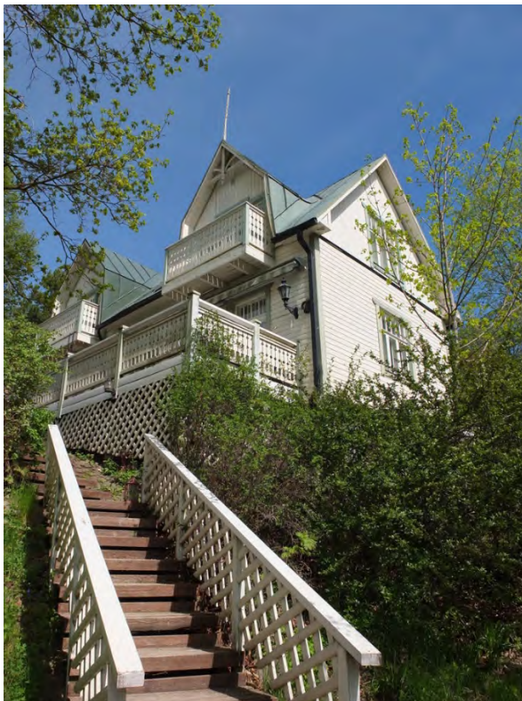
Bild: Ett gammalt torp har fått en ny fasadbeklädnad, nytt tak och nya fönster. I byggnadsinventeringen konstateras att det har gjorts ändringar i byggnaden. Stenfoten av naturstenar avslöjar att det är fråga om ett gammalt hus som byggts innan betong började användas. Foto: Teija Mustonen, Åbo museicentral/MIP
