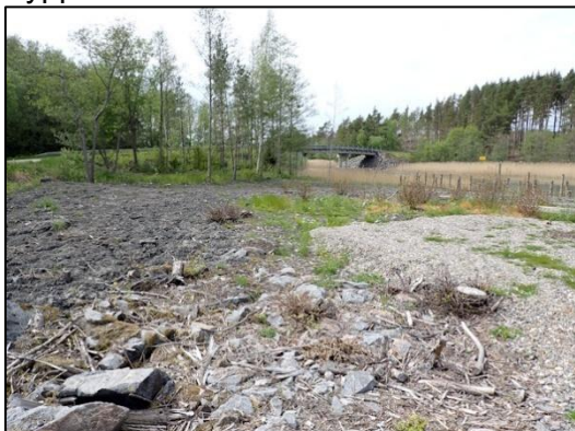
Kuva 15. Näkymä kohteen länsiosasta.
