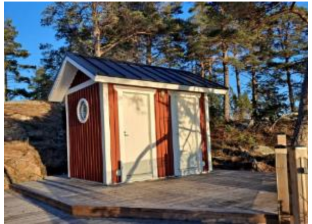
Bild 16. Toalettbyggnad vid stranden.
