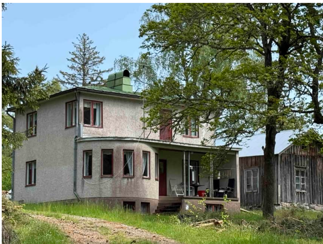
100 m väster om planområdet ligger en 2 vån putsad bostadsbyggnad. (Foto AS 2025)
