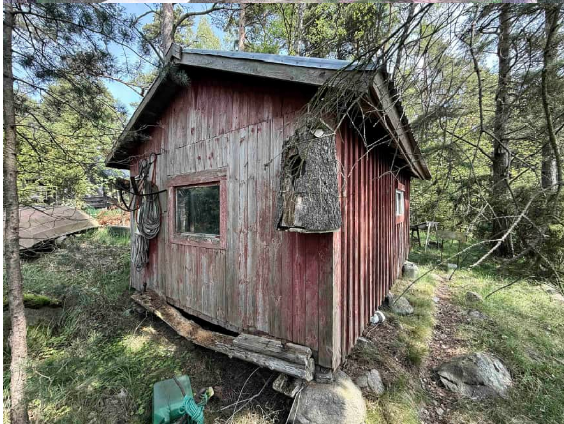
Ekonomibyggnad, strandbastu, bryggförråd (foto AS 2025)
